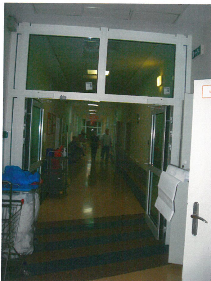
Widok istniejącej przegrody szklanej w klasie EI30 odporności ogniowej.
